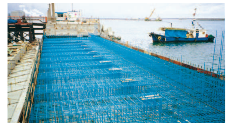
青森県八戸港管理事務所殿・八戸シーガルブリッジ(橋梁下部)
