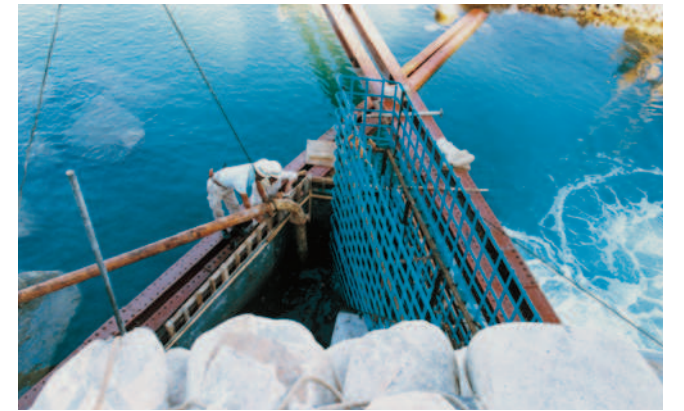
発電所 海水取入口
