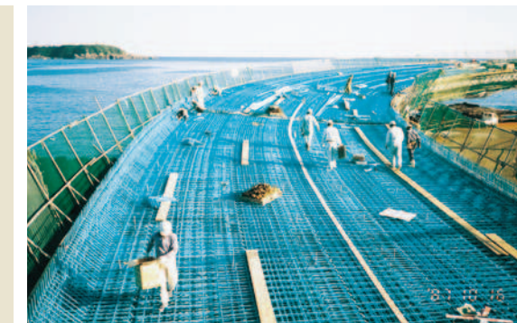
道路橋使用例
