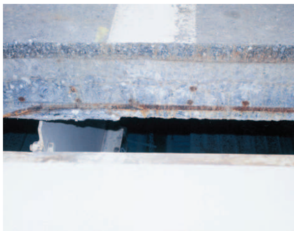
24年間の凍結防止剤散布により塩害を受け全面取り替えされた高速道路床版（中央自動車道・山梨県内） 提供：『日経コンストラクション』93年11月20日号 撮影：馬島氏
