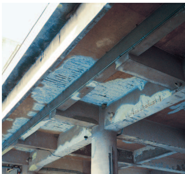
鉄筋腐食による構造物劣化
