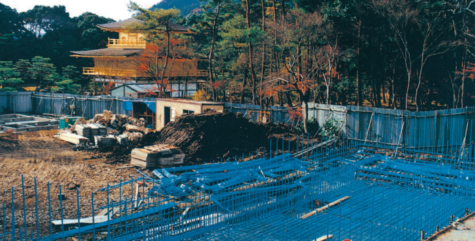
鹿苑寺(金閣寺)防災施設工事
