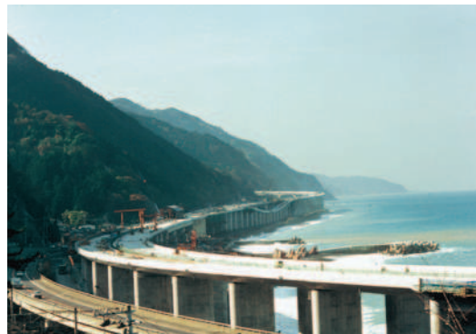
日本道路公団新潟建設局殿 北陸自動車道・親不知高架橋
