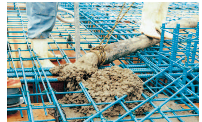
コンクリート打設
