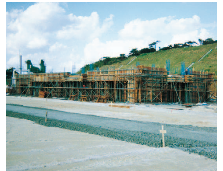
東京都港湾局殿・神津島空港ターミナル、消防署（全面使用）
