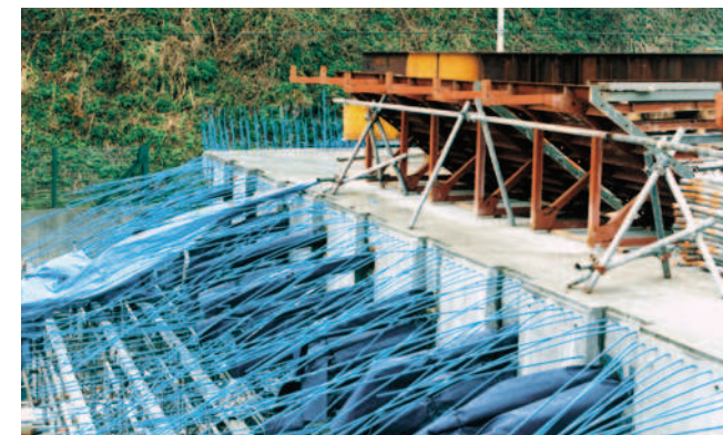
道路打ち継ぎ部
