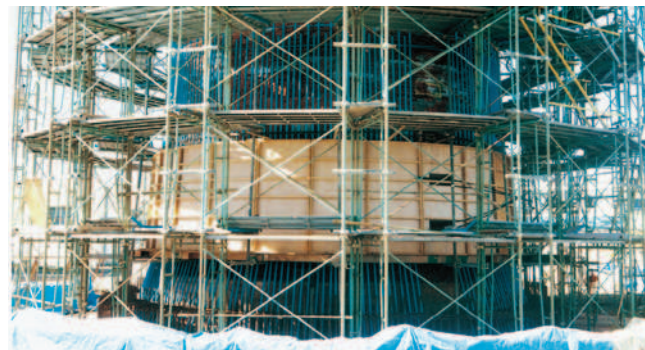
第三管区海上保安本部殿 犬吠埼灯台改修工事
