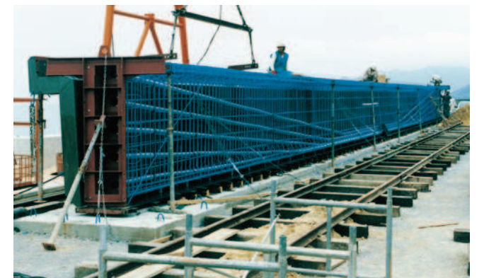
沖縄開発庁北部国道事務所殿・源河橋工事
