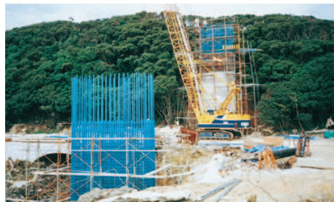
和歌山県串本土事務所殿 (橋脚)
