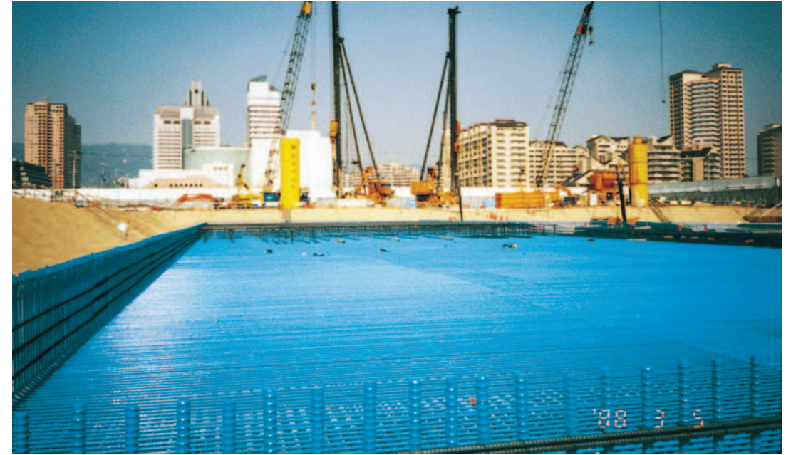
神戸市都市整備公社殿 六甲アイランド建築基礎
