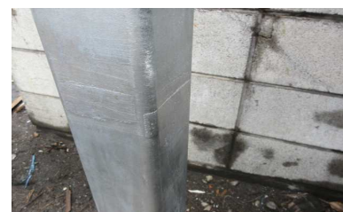
AG-EGALの施工例
